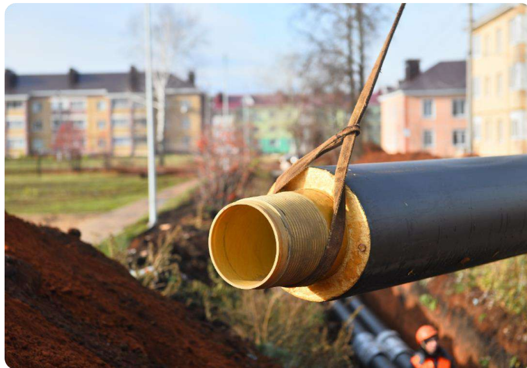
НАЗЕМНАЯ И ПОДЗЕМНАЯ (БЕСКАНАЛЬНАЯ) ПРОКЛАДКА
