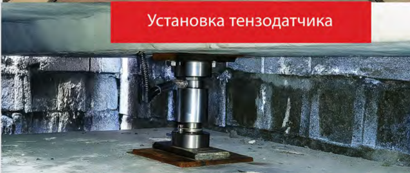
Монтаж и настройка весов
