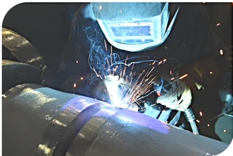
Сварка труб толщиной стенки 20 мм с применением втулки ГЕРМЕТ-К
